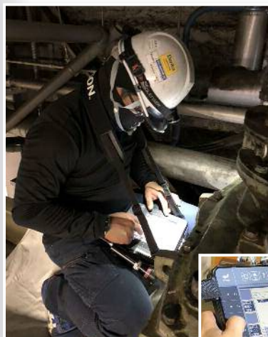
▲振動測定の様子
